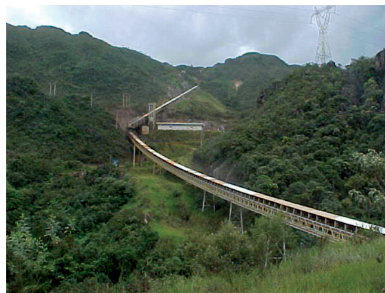
Correia Transportadora - Terminal Ferroviário de Andaime
