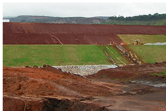
Barragem de rejeito de Brucutu
