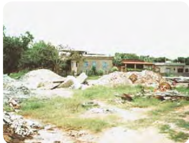
Foto 64. Acúmulo de resíduos gerados
