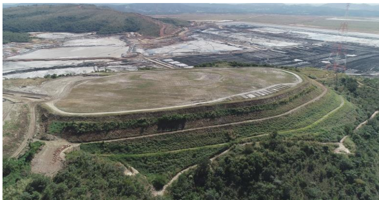
2020 – Manutenção Tanque VI e revegetação da camada de trafegabilidade
